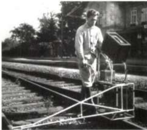
1. kép. A Kretztechnik sínvizsgálója, mellyel a „vesealakú” sínhibákat keresik
