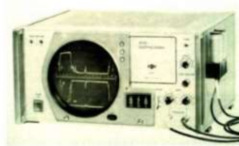
2. kép. Talán megbocsátható hengegés: EMG1145 tip, Echoencefalográf. Az agyi középvonalat két oldalról méri, 1 és 2 MHz-es egyvelemes fejekkel. A parallaxishiba kiküszöbölése érdekében mm-ben számokkal is kijelzi (1977)
