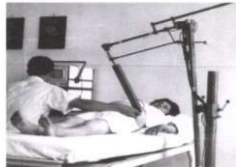
6a-b. képek. Compound scanner. A csuklóban levő potenciométerek adják az információt az elektronikának a transzducer pozíciójáról és a nyaláb irányáról. Kretztechnik. 1967
